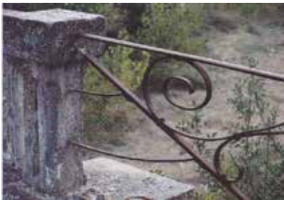
Piezas de protección. Se observan el pilarcillo o dado ranurado, para unión de barandillas de forja, o petos prefabricados de hormigón
