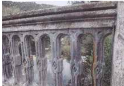
Piezas de protección. Se observan el pilarcillo o dado ranurado, para unión de barandillas de forja, o petos prefabricados de hormigón
