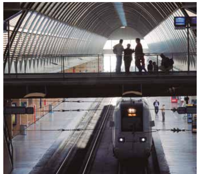
Estación AVE Santa Justa Sevilla
