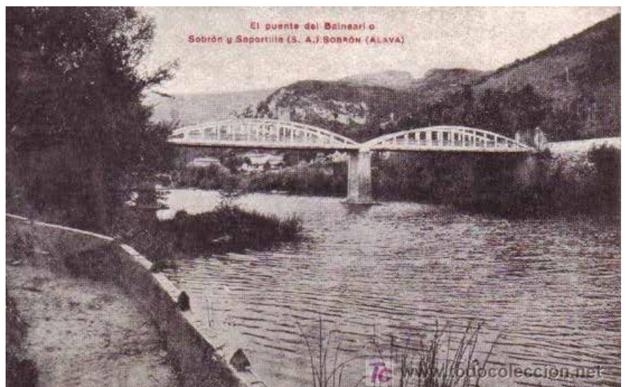
Vistas del Puente de Sobrón. Aguas abajo desde el Paseo Alameda, de Soportilla (Burgos)
