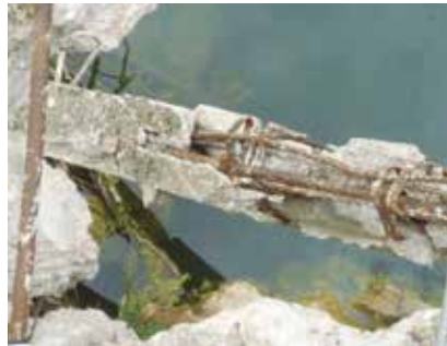
El caos se hace visible, al bajar el nivel del agua. Sin romper su enlace solidario por los redondos (barras de hierro) la herrumbre avanza en ocres en el aire o el agua. La nieve y la vegetación matizan sus fragmentos en verdín o blanco, según la estación
