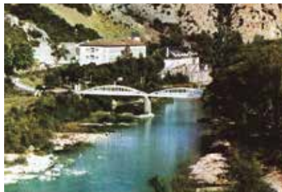
Izda._ 'Puente Blanco'. Vista aérea completa de la Rampa de acceso a Soportilla –margen burgalesa– desde el monte que alberga el Manantial
