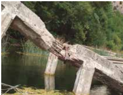
El caos se hace visible, al bajar el nivel del agua. Sin romper su enlace solidario por los redondos (barras de hierro) la herrumbre avanza en ocres en el aire o el agua. La nieve y la vegetación matizan sus fragmentos en verdín o blanco, según la estación
