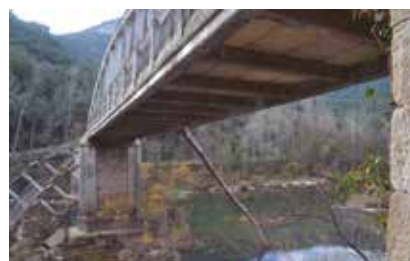
Elementos constructivos que revelan el diseño creativo del autor. Pila central de apoyo de los arcos bowstring , que a su vez soportan los tableros; los estribos; barra de montante biselada, estriada, y cajeadada; traviesas del tablero; apoyo de un arco en la base de la pila; y riostras del arco
