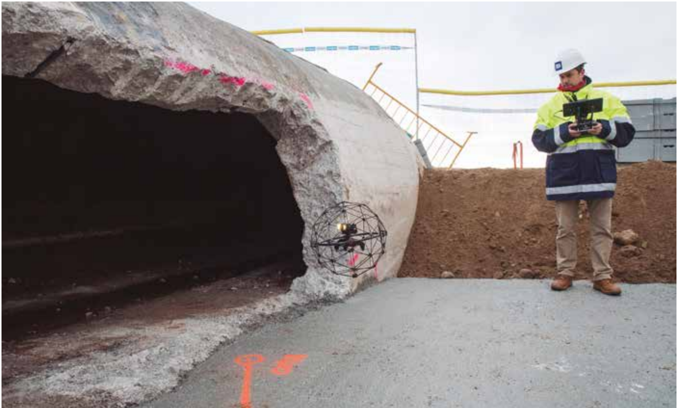
Trabajos de inspección del Colector de Levante (Badalona) mediante un dron, 2017
