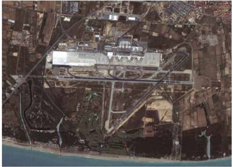
Transformación del Aeropuerto de Barcelona 1999-2009 Fuente: Aena
