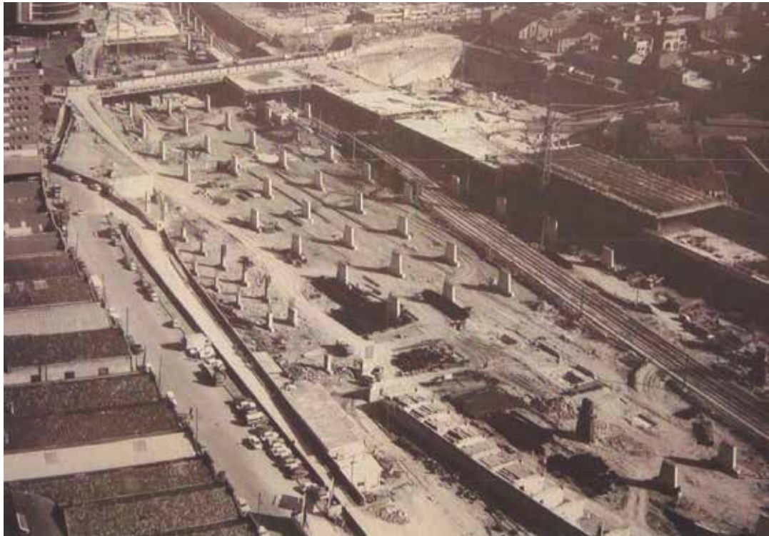
Estación de Sants en proceso de construcción en la década de los años 70 del siglo XX, manteniendo en servicio la línea ferroviaria existente. Fuente: ADIF
