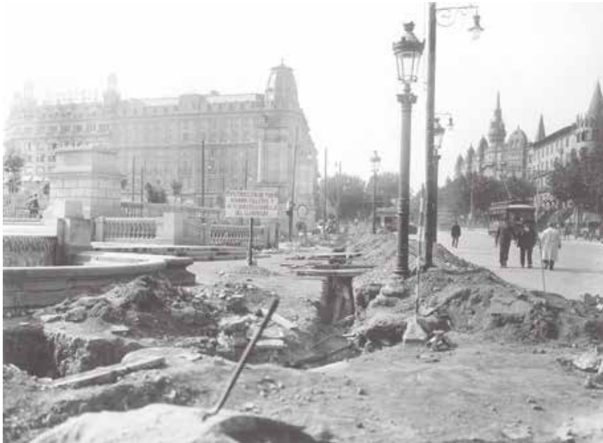
Arriba_ Instalación de tuberías Bonna en Plaza de Catalunya con Paseo de Gracia al fondo (1927)
