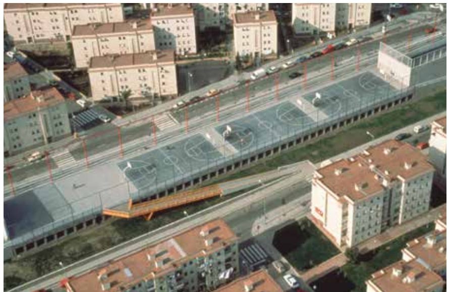
Cobertura Ronda de Dalt, 1992
