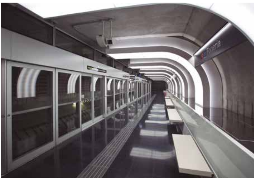
Fig. 5_ Fotografía andenes estación L9 dentro del túnel y estación con ascensores de gran capacidad
