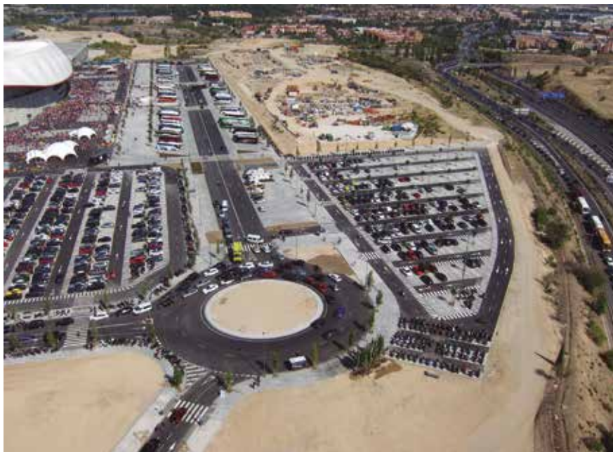
Fig. 4_ Vista general fachada este (Fuente: FCC Construcción)
