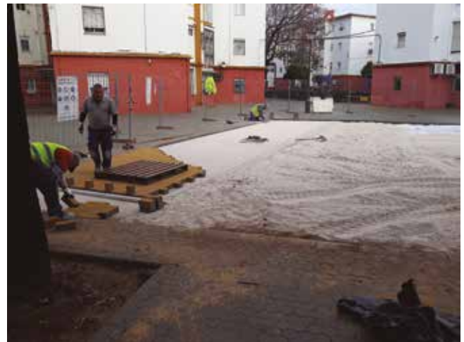
Fig. 3_ Última fase de ejecución: pavimentación mediante adoquín permeable
