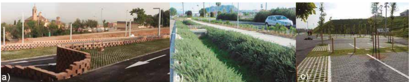
Fig.1_ SuDS de proyectos I+D+i en España; a) Aparcamiento permeable en Granada; b) Cuenta verde en Xàtiva, Valencia; c) Aparcamiento permeable en Las Llamas, Santander. Elaboración propia
