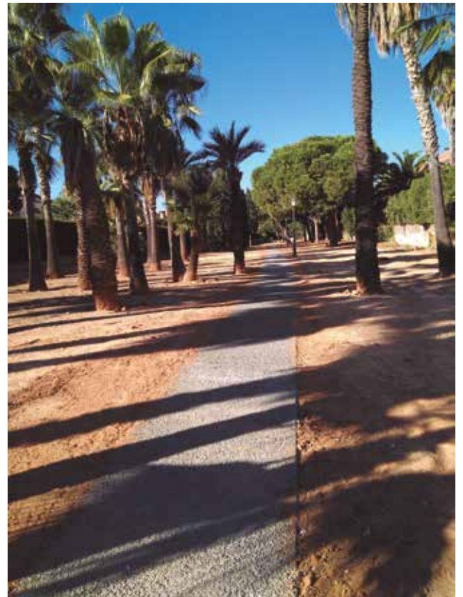
Zanja drenante Mas Camarena
