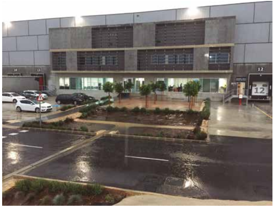
Balsa de biorretención IV3
