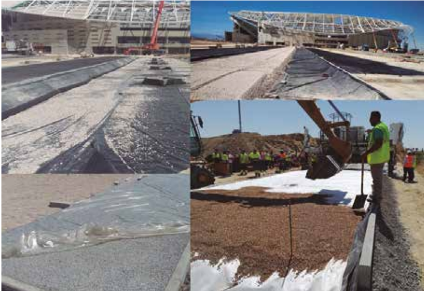
Fig. 2_ De izquierda a derecha y de arriba abajo: geotextil impermeable en coronación de explanada; subbase de grava de 35 cm de espesor; geotextil no tejido 100% polipropileno de fibra virgen; 5 cm de gravillín; capa de rodadura de 20 cm de espesor de hormigón drenante
