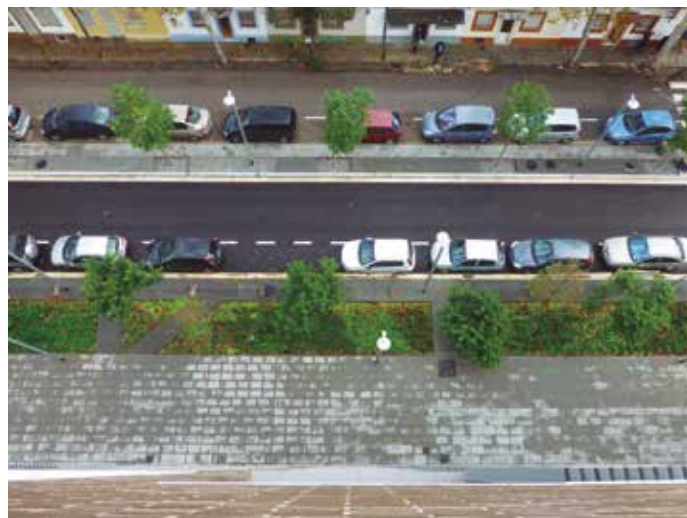
Urbanización del barrio de Bon Pastor
