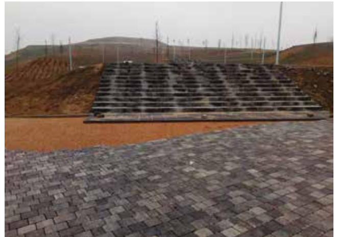
Fig. 8 y 9_ Colocación del adoquín permeable por junta sobre gravillín
