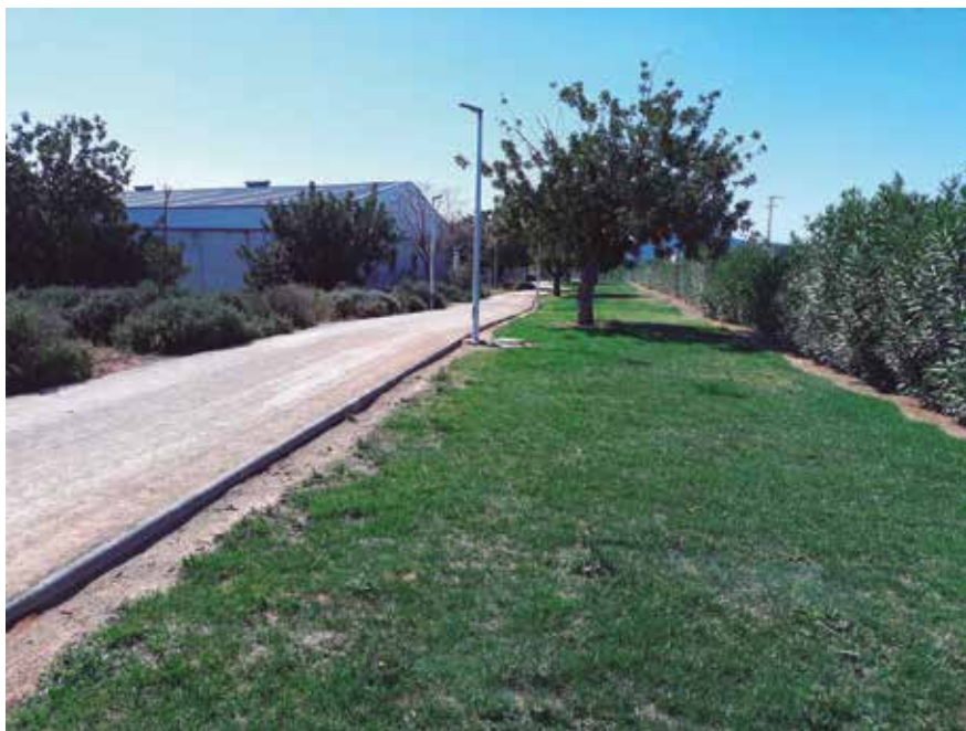
Fig. 4_ Jardín de lluvia en la remodelación del parque del Polígono Industrial Les Eres
