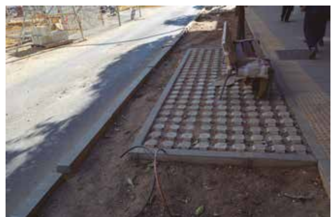
Fig.5_ (a) Sección constructiva de los SUDS diseñados en Avd. El Greco (b) Ejecución de una de las áreas de biorretención en acerado
