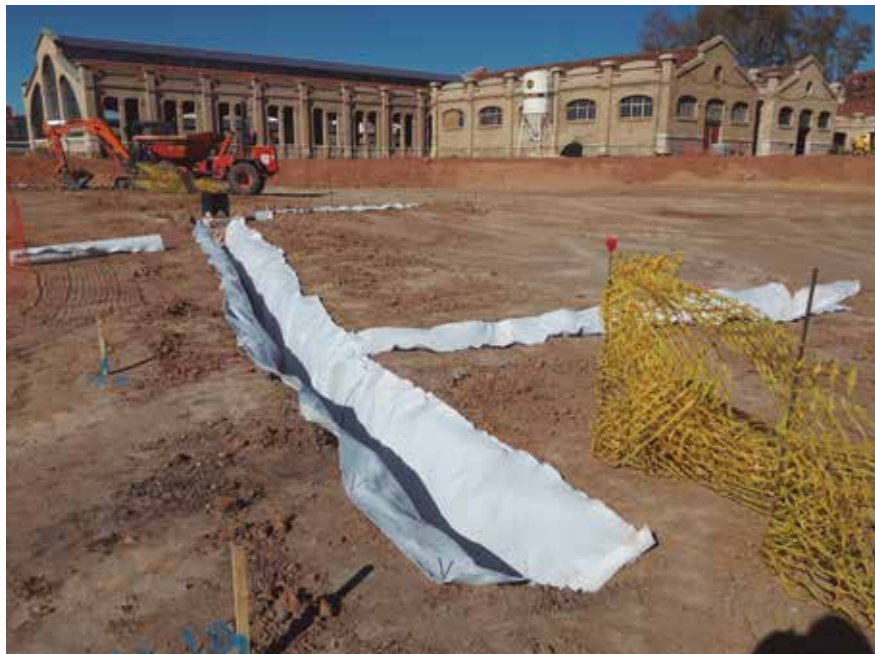
Fig. 3_ Zanjas drenantes y sondeo de infiltración en el Parque Central
