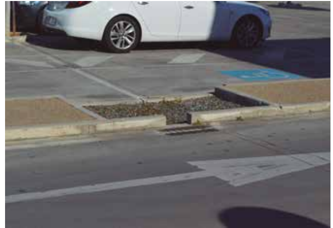
Fig. 2_ Pozo e imbornal drenante ejecutado en playa de aparcamientos
