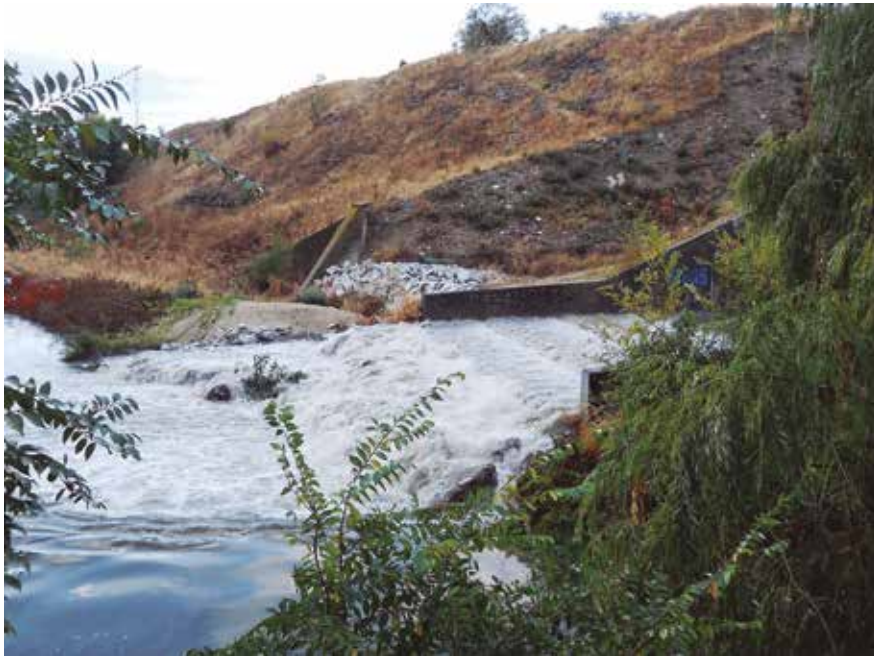
Aliviadero del tanque de tormenta de Butarque
