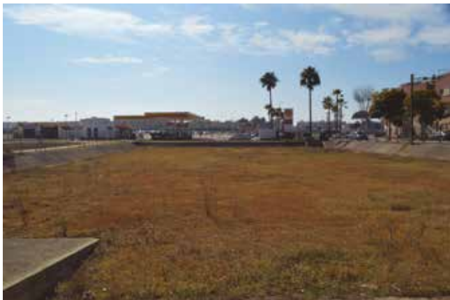
Fig. 1_ Vaso de detención ubicado en Avd. Juan Pablo II
