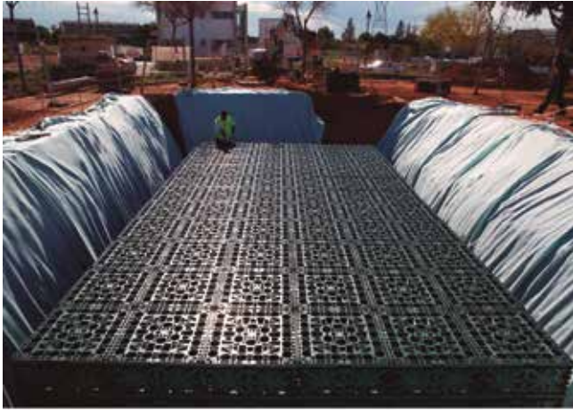
Depósito de infiltración con bloques ecobloc light
