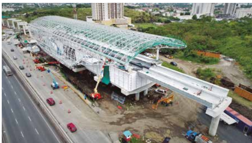
Estación 24 de Diciembre
