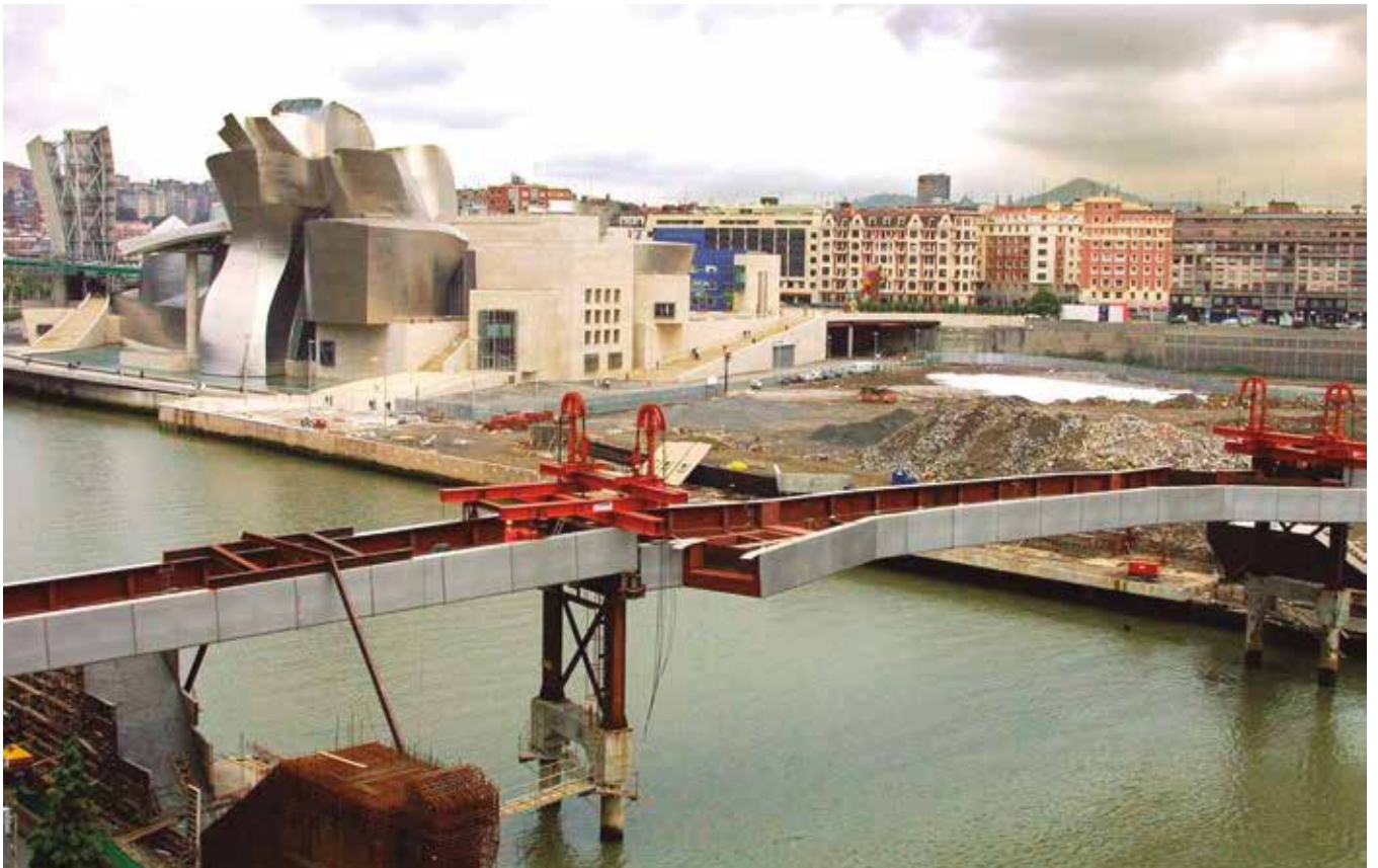
Fig. 3_ Proceso de construcción de la pasarela de Abandoibarra en Bilbao (foto cortesía de IDEAM)
