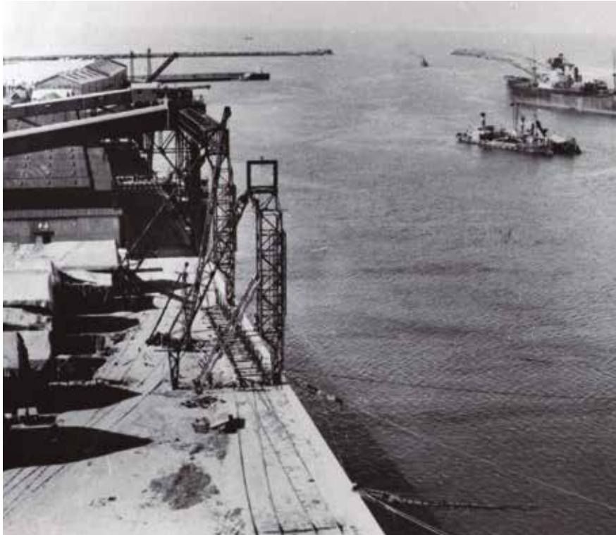
Fig. 5_ Muelle Puerto Quequén y vista de escolleras 1936
