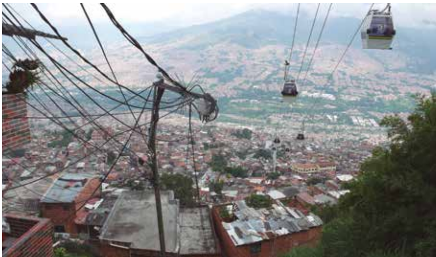
Acceso a un poblado de Medellín en Metrocable. Foto C. N.
