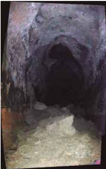
Fig. 13_ Hundimiento por techo plano y perfil real obtenido con láser escaner
