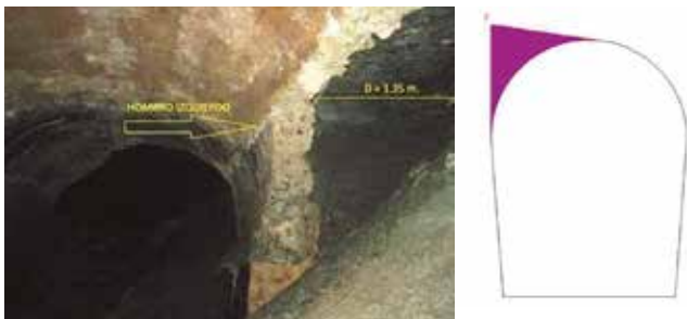
Fig. 9_ Desprendimiento lateral
