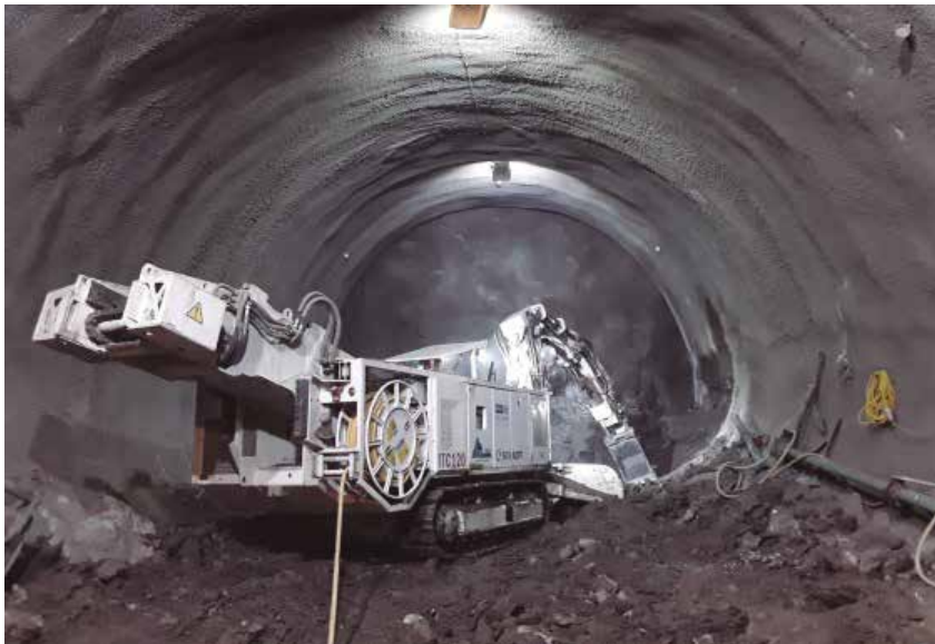
Fig. 12_ Excavación de contrabóveda en las proximidades del frente con ITC 120
