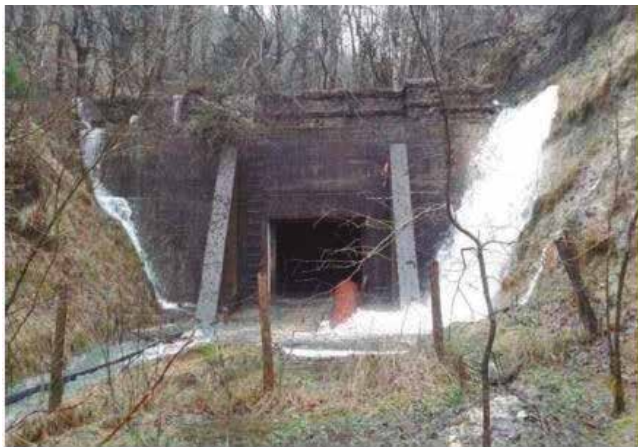
Boca norte del túnel de Laminoria (Fuente: Anteproyecto constructivo de obras para restauración y acondicionamiento del túnel de Laminoria en el trazado de la vía verde del antiguo ferrocarril Vasco-Navarro, febrero 2015)
