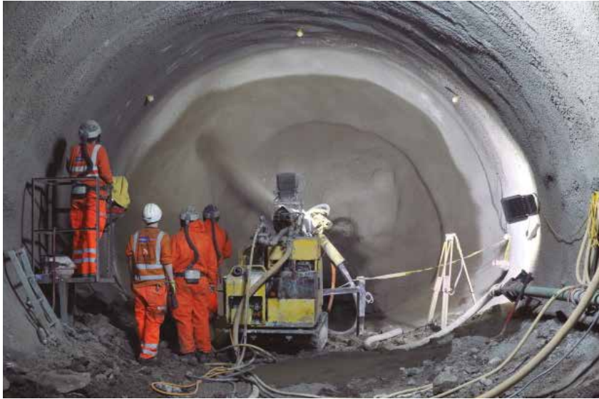
Fig. 11_ Proyección de hormigón de sostenimiento
