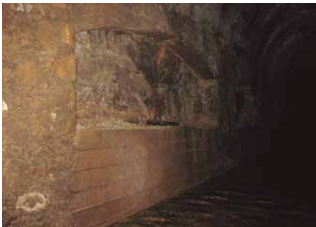
Fig. 3_ Refuerzo del revestimiento
