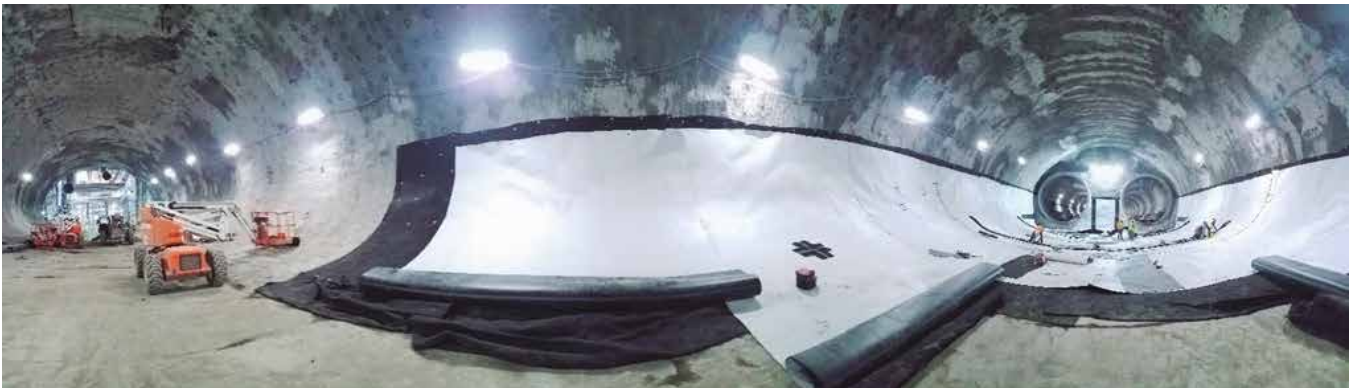
Fig. 6_ Excavación de la caverna finalizada y puesta en obra de impermeabilización en curso
