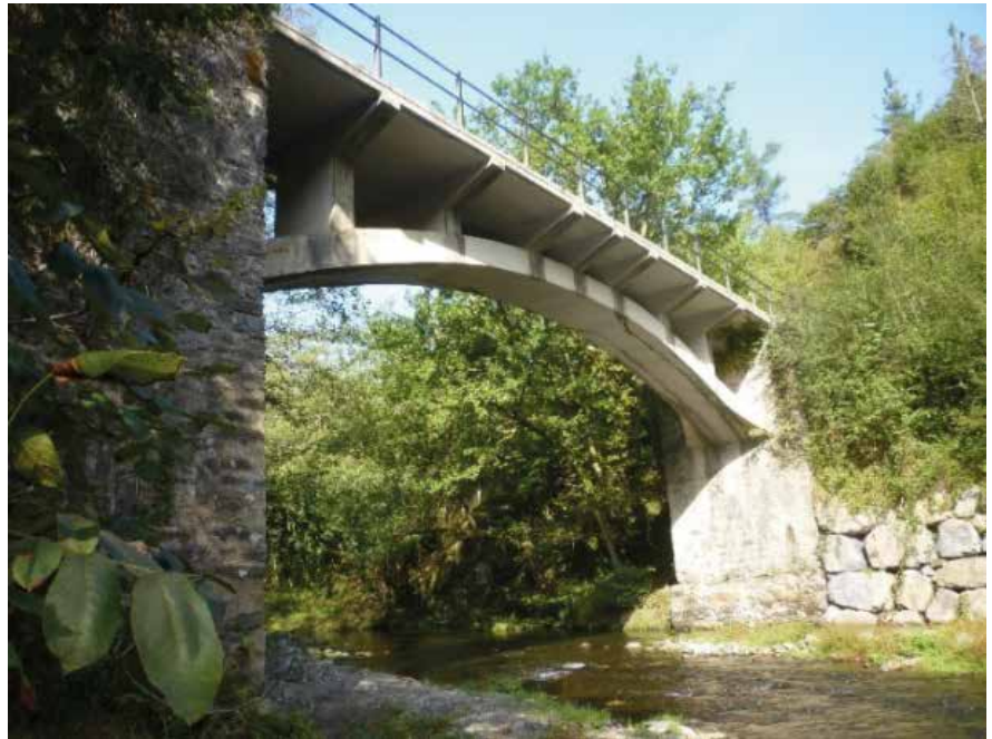
Fig. 2_ Trazo del arco único rebajado de Oloqui. El diseño recalca su ensanche en los estribos y las traviesas en ménsula sobre los montantes que forman una 'caja armada' como tablero, protectora en los descarrilamientos. Imagen del autor, 2016
