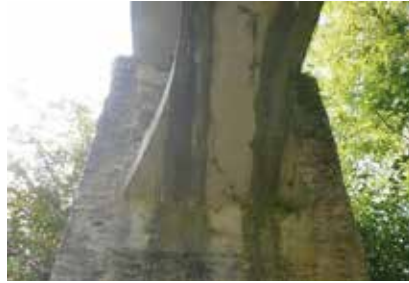
Fig. 5_ El puente de HA de Olloqui. Imagen con el caserío navarro entre la vegetación y detalle del empotramiento del arco único, que amplía su ancho al acometer el estribo. Fotografías del autor, 2016
