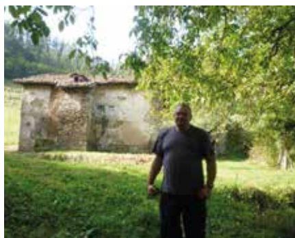
Fig. 14_ Olloqui. El caserío situado junto al puente del tren y su casero. La Ferrería, los hornos con sus anteparas –bocas de acceso– en proceso de limpieza y restauración cercanos a la presa de piedra (de mediados del XVIII), anteriormente represa de madera. (Fotografía del autor, 2016; y de X. Cabezón, 2006)
