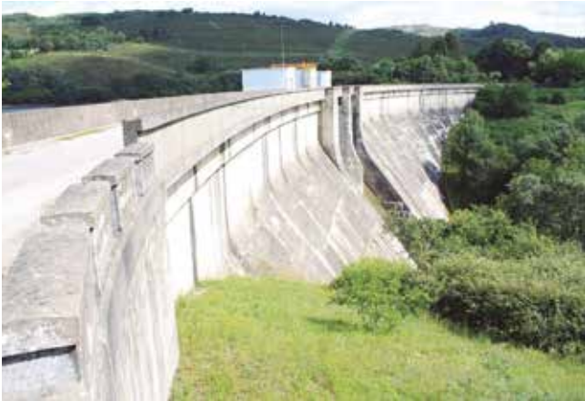
Fig. 7_ Presa de Salas
