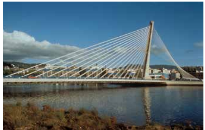
Puente atirantado sobre el río Lézec. Pontevedra. 125 m de luz. 1995
