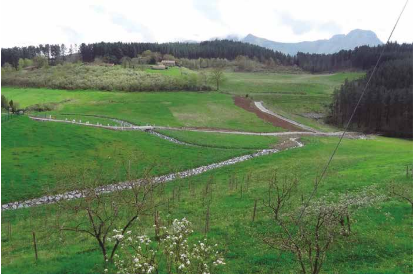
Fig. 18_ Integración ambiental del falso túnel de Gaztelua. Estado actual
