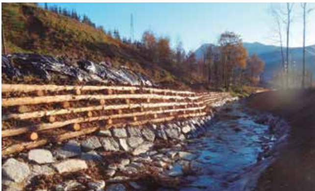
Fig. 20_ Muro Krainer, tras su ejecución
