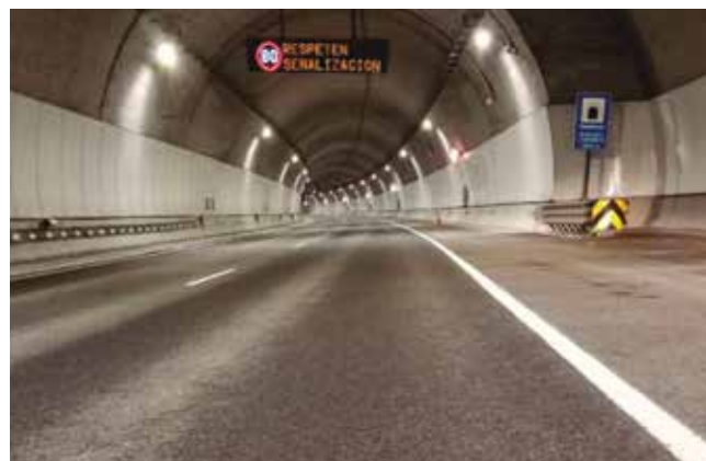
Fig. 13_ Túnel de Gaztelua finalizado
