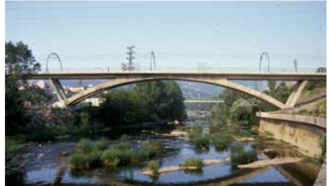
Puente arco de Bolueta sobre el río Nervión. Bilbao. 63 m de luz. 2003
