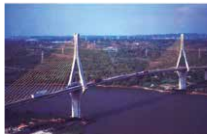
Fig. 4_ Puente Ingeniero Antonio Dovalí Jaime en la región de Minatitlán, Veracruz. Considerado uno de los puentes atirantados más representativos de México, su imagen nos evoca arpas en concierto, en este caso, arpas en abanico de singular belleza (www.revistaconstruye.com.)
