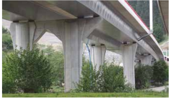
Fig. 15_ Detalle de apoyo excéntrico en Pila 10 para respetar la cuenca del arroyo Zaldú.
