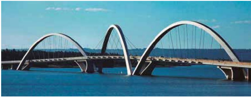
Fig. 1_ Puente Juscelino Kubitschek, Brasilia. Los arcos no se encuentran en el mismo plano y los cables de suspensión forman una superficie parabólica. Esta versión grácil, dinámica y mágica del arco sugiere una clara imagen de lo que fue el arpa primitiva. Sin duda, un paisaje idílico para simular la figura de un arpa en forma de arco (seonegativo.com)
