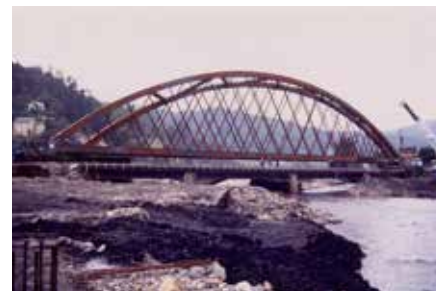
Puente sobre el río Besós. Barcelona. 68 m de luz. 1989 Puente de Castejón sobre el río Ebro. 100 m de luz. Navarra 1972 Puente sobre el río Caudal en Mieres. 80 m de luz. Asturias (1992)
