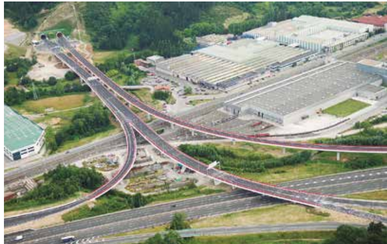
Fig. 6_ Vista general de la OF 1.1
