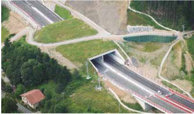
Fig. 14_ Falso túnel de Atxondo como paso de fauna
