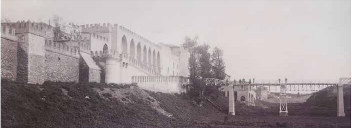
Fig. 2_ Fachada posterior al campo de maniobras 1914. Fuente: Archivo General Militar
