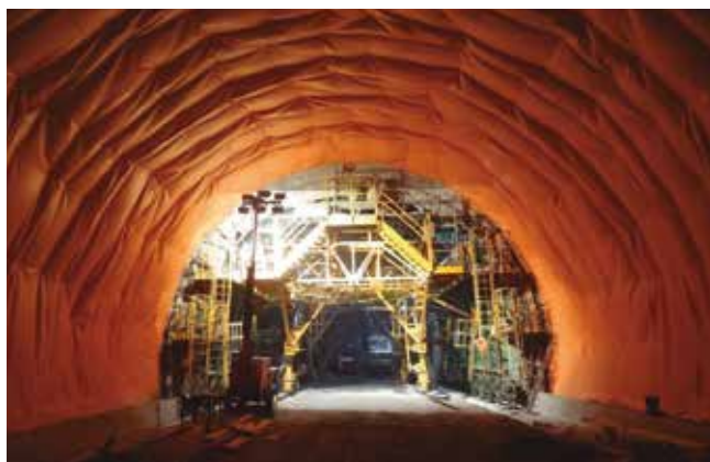
Fig. 12_ Vista de impermeabilización y carro de revestimiento en el túnel de Gaztelua
