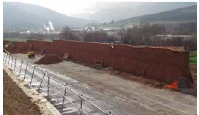
Fig. 21_ Pantallas vegetales en el enlace de Muntzaratz
