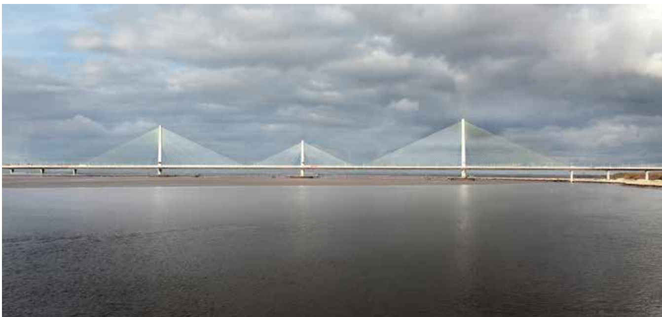
Puente sobre el río Mersey (Liverpool)
