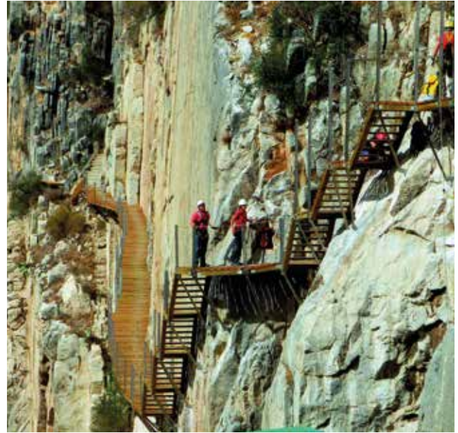
Trabajos de ejecución del nuevo camino
