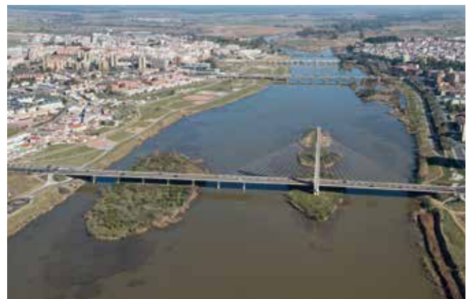
Vista general del tramo urbano
