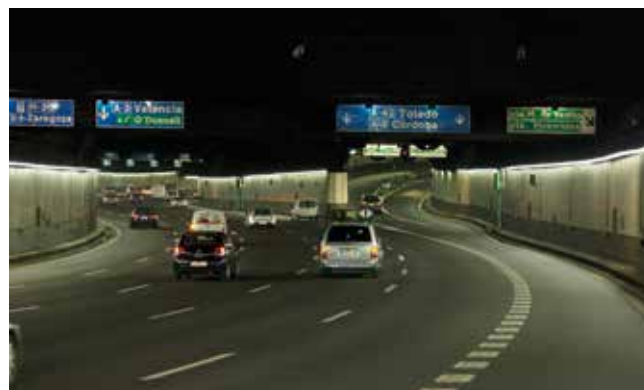
Túneles de la M-30
