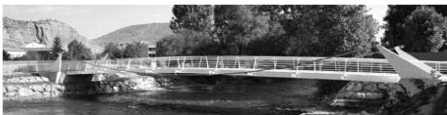
Pasarela sobre el río Najerilla (La Rioja)
