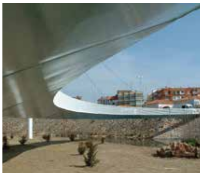
Pasarela de San Juan de la Cruz sobre el río Carrión (Palencia)
