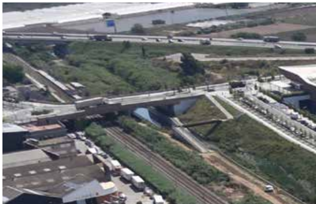
Puente de la Carretera de la Vila
