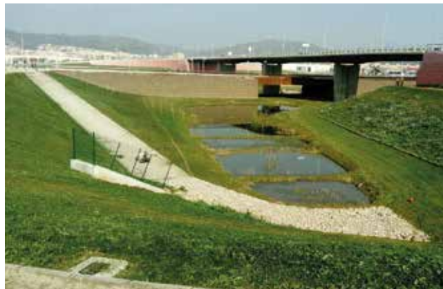
Balsa de laminación de Ca n'Alemany – Parc Central
