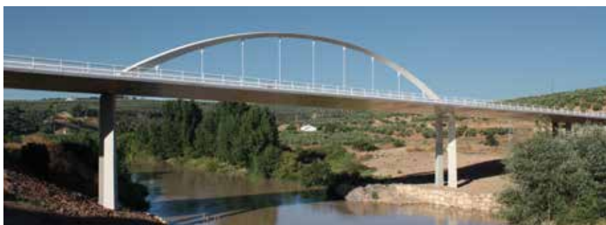
Puente sobre el río Guadalquivir (Montoro)
