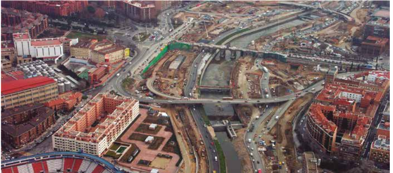
Ejecución de las obras a la altura del Puente de Toledo
