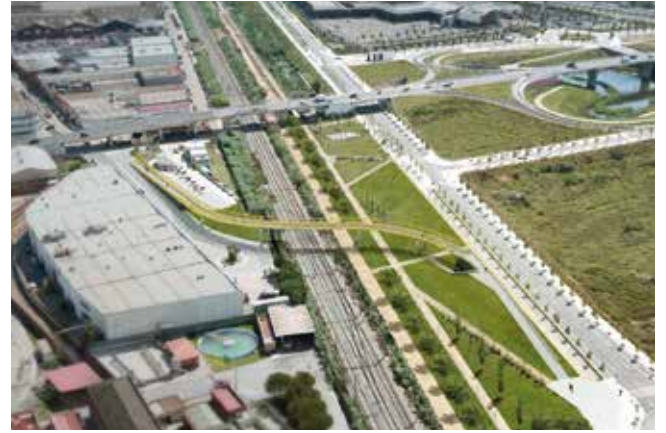
Pasarela peatonal de Ca n'Alemaný
