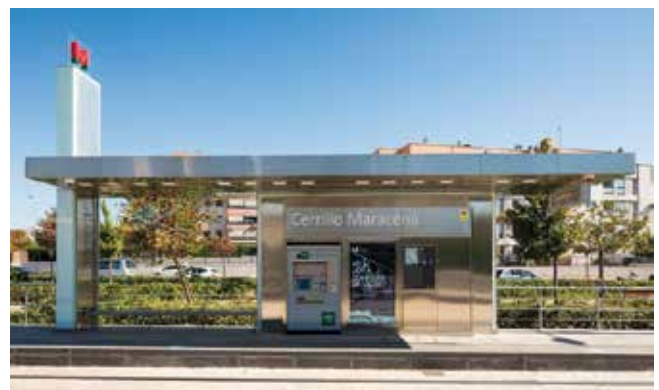
Marquesina en Cerrillo Maracena
