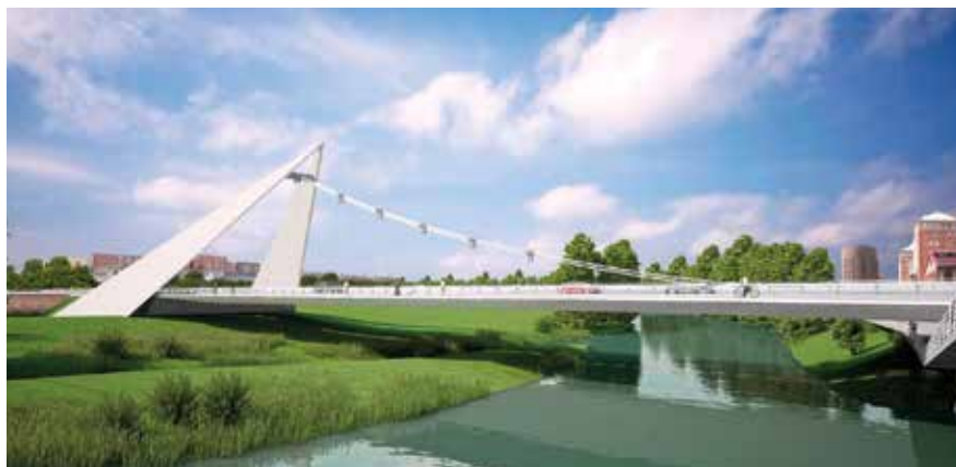
Puente de Cuatro Vientos (Pamplona)
