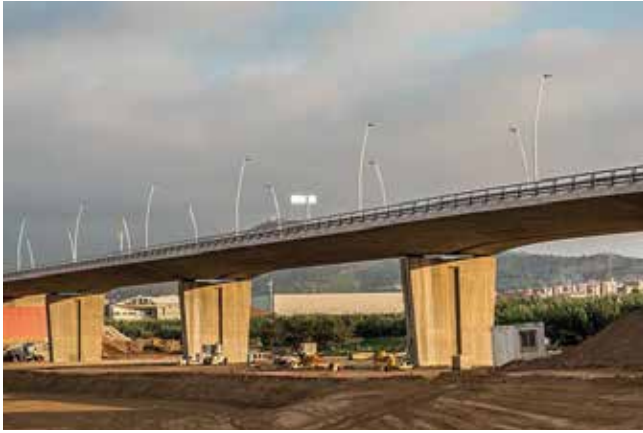
Viaducto de Ca n'Alemaný
