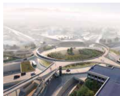
Pasarela Padre Anchieta (Tenerife)
