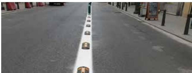
Fig. 3_ Separación del carril bus mediante módulos de plástico reciclado rebasables (Valencia)
