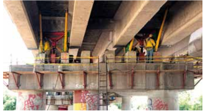
Fig. 6_ Vista frontal de la Pila 3 durante el proceso de elevación del cuarto vano. Fuente: Civing, S.A. de C.V.
