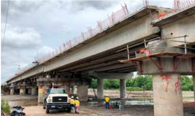
Fig. 5_ Vista desde aguas arriba de la elevación del cuarto vano; al fondo se aprecia el primero ya apoyado. Fuente: Civing, S.A. de C.V. En https://www.facebook.com/CIVINGSAdCV/videos/480975516078423/ puede encontrarse un video del proceso con varias tomas en time-lapse de la elevación del tablero
