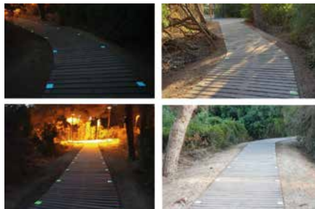
Fig. 7_ Losetas convexas en itinerario peatonal. Parque Natural de L'Albufera
