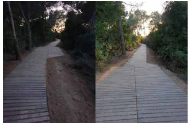
Fig. 2_ Pasarela mediante listones de plástico reciclado y paja de arroz. Parque de L'Albufera (Valencia)
