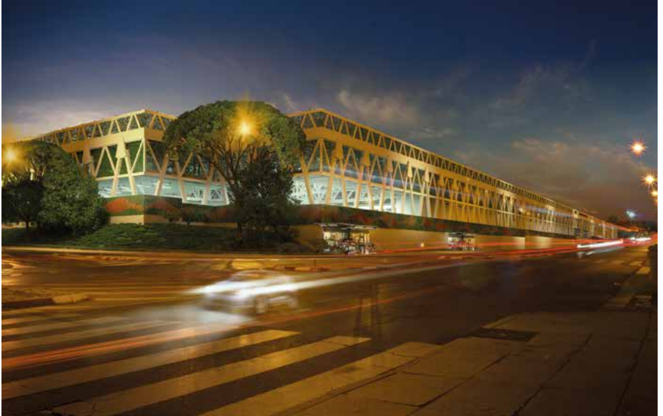
Fig. 2_ Estado actual del Centro de La Elipa. Fuente: proyecto original
