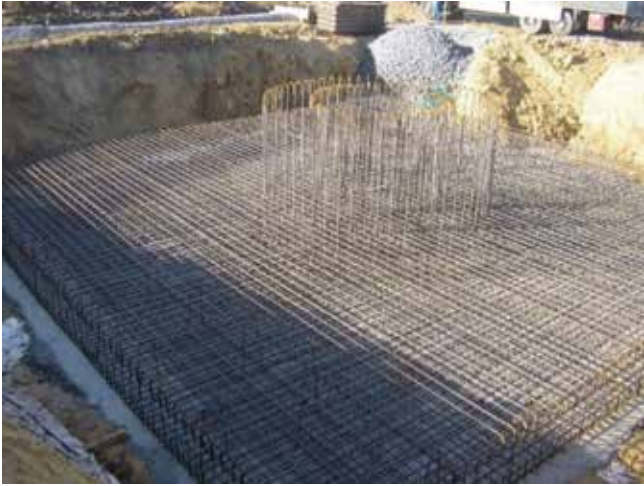
Fig. 4_ Armado y virola de cimentación para turbina V-52, 850 kW HH65. Fuente: Parque Eólico Codesas, La Coruña, Naturgy
