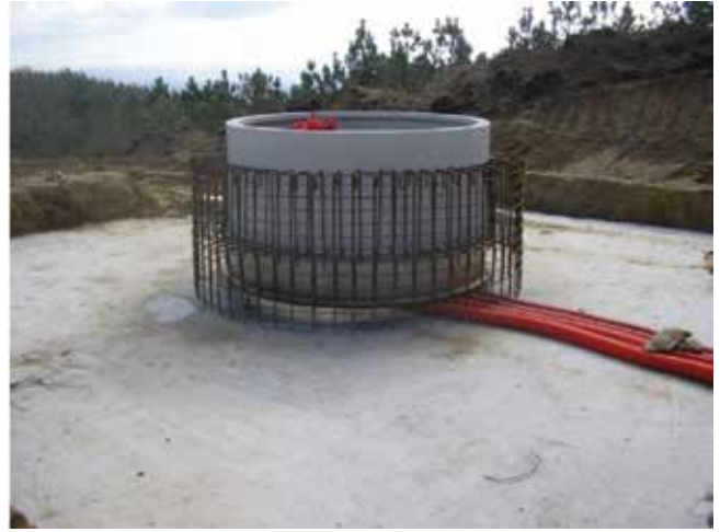
Fig. 4_ Armado y virola de cimentación para turbina V-52, 850 kW HH65. Fuente: Parque Eólico Codesas, La Coruña, Naturgy
