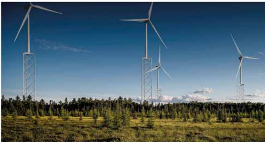
Fig. 18. Nabralift Prototipo de 160m y objetivo 200 m. Fuente: Nabrawind
