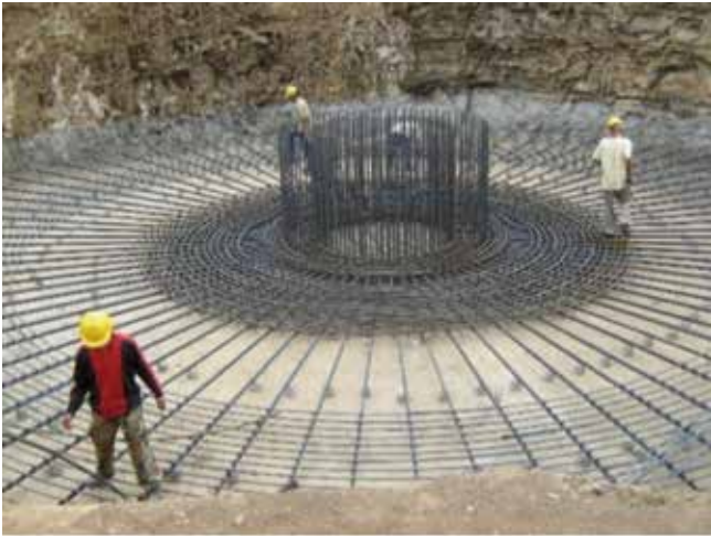
Fig. 6_ Construcción cimentación para turbina S88 HH79.2 m (2,1MW). Fuente: Parque Eólico de Amayo, Nicaragua, GPG IDG
