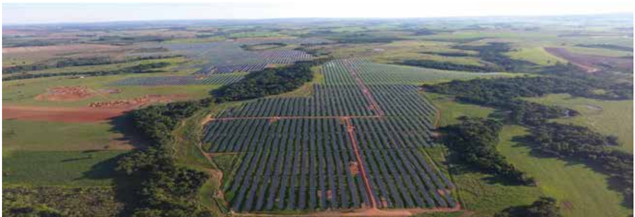
Fig. 20_ Planta Fotovoltaica Guimarania I&II, Minas Gerais, Brasil 83MWp. Fuente: GPG
