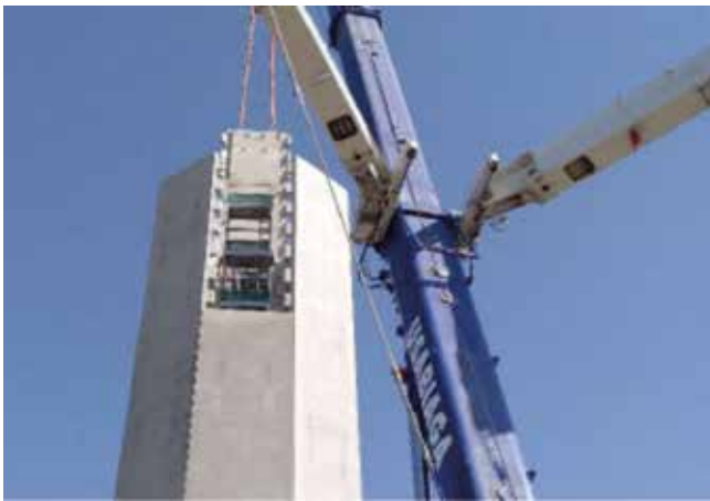
Fig. 17_ Montaje de dovelas en torre prefabricada de hormigón. Fuente: Torre Ventur para ACCIONA. Parques Eólicos de la Mudarra y Barasoain, Naturgy
