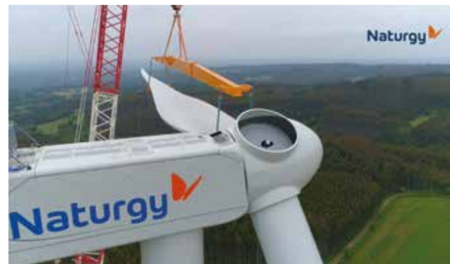
Fig. 16_ Izado de palas G132 HH 84m 3,465 MW. Fuente: Parque Eólico Pastoriza, Lugo. Naturgy
