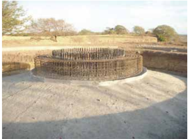
Fig. 6_ Construcción cimentación para turbina S88 HH79.2 m (2,1MW). Fuente: Parque Eólico de Amayo, Nicaragua, GPG IDG
