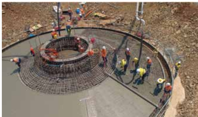
Fig. 8_ Construcción cimentación turbinas GE130 - 3,43 MW 95HH y SG-145, 4,2MW HH90. Fuente: Parque Eólico Crookwell 2, Australia y Parque Eólico Cabo Leones 2. GPG e IBEREOLICA
