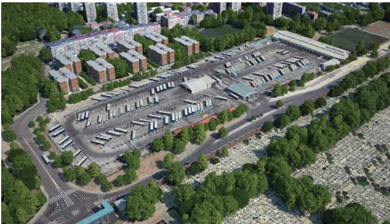
Fig. 1_ Estado actual del Centro de La Elipa. Fuente: proyecto original
