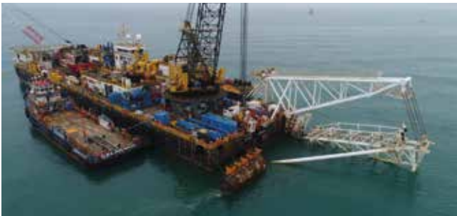
Foto 7_ Izado de la TBM desde embarcación principal
