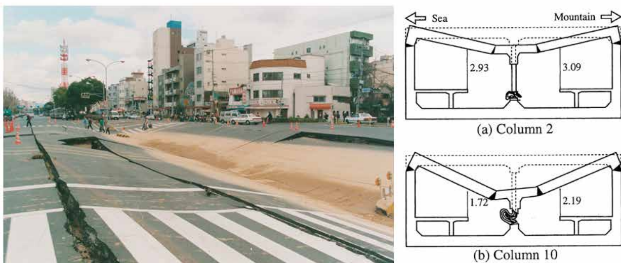
Fig. 1_ Rotura y hundimiento de la losa superior de la estación de Daikai en Kobe (1995). Estado resultante en superficie. Fuente: lida et al 1999, foto: Kobe City Council.
