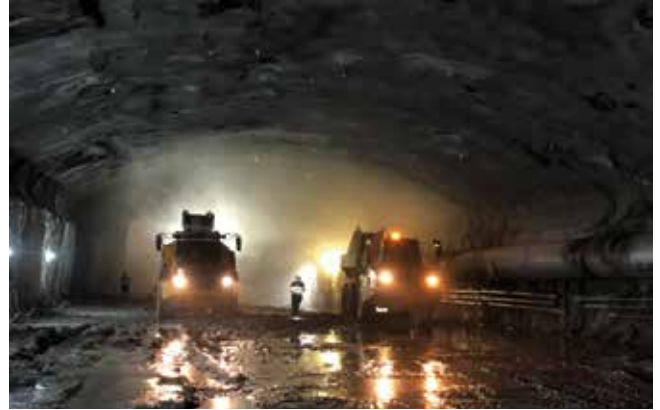
Fig. 8_ Excavación simultánea con dos rozadoras en paralelo en túnel de 4 carriles
