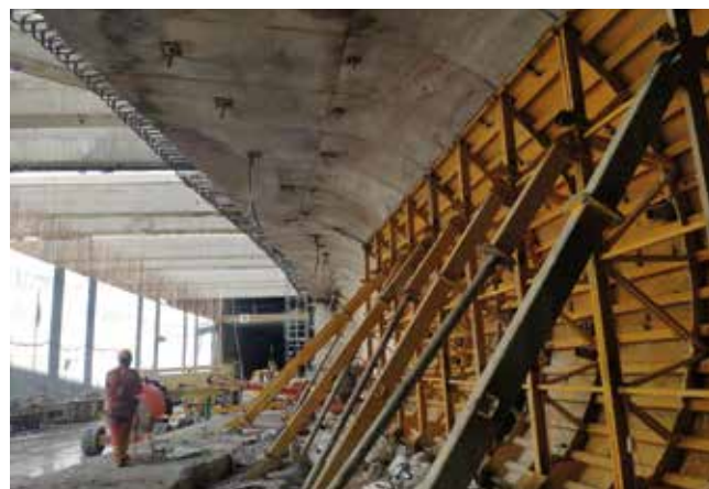
Fig 10_ Instalación de módulos encofrado
