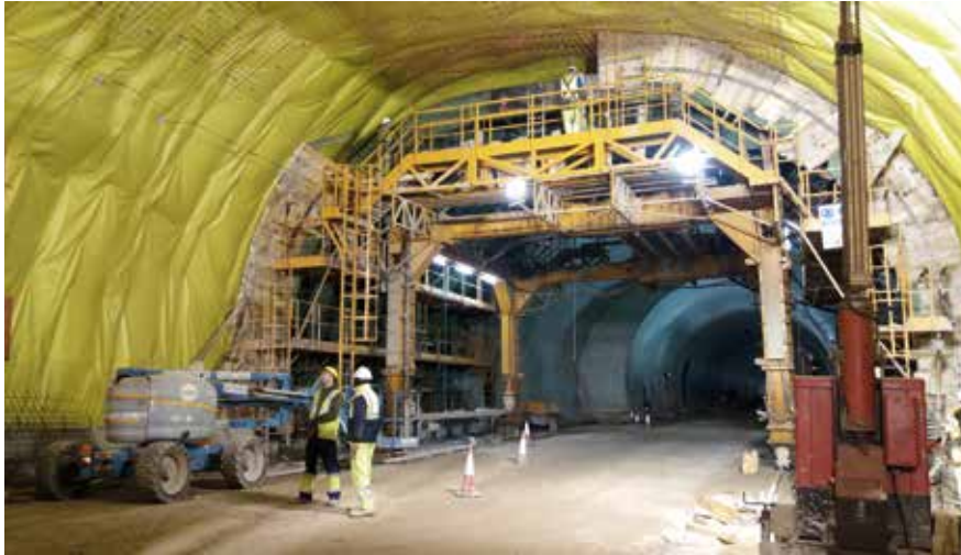
Foto 7_ Ejecución del revestimiento
