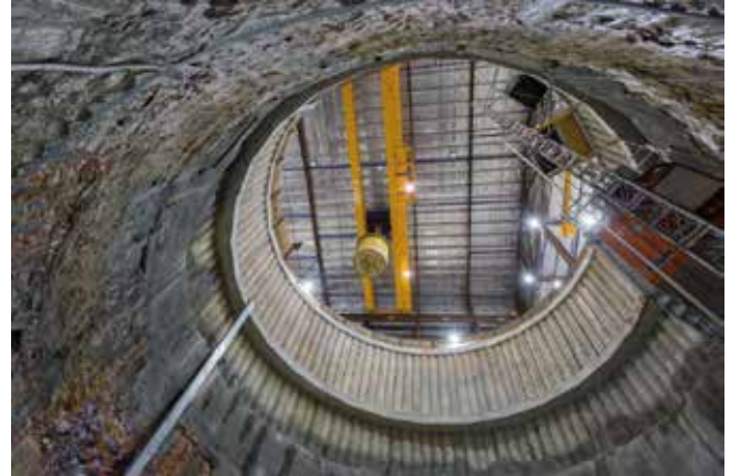
Fig. 6_ Ejecución de las obras desde instalaciones insonorizadas para minimizar el impacto ambiental
