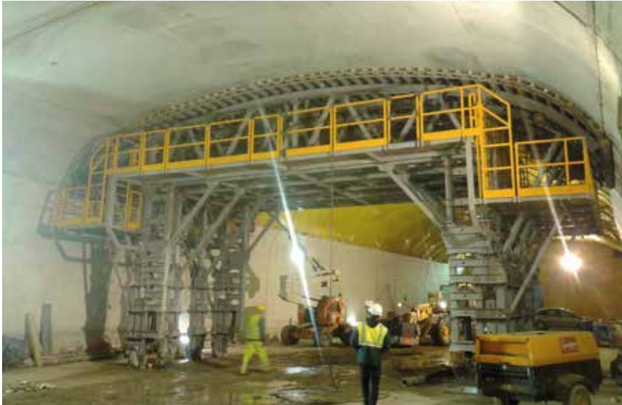
Foto 5_ Revestimiento de cuarto técnico
