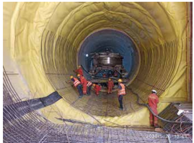
Fig 9_ Membrana de impermeabilización y armado en nicho y escudo de EPB. Accionamiento de la TBM al final
