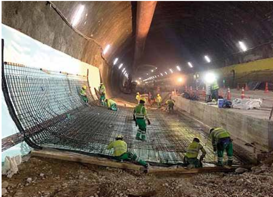
Fig. 3.2.b_ Construcción de la contrabóveda armada
