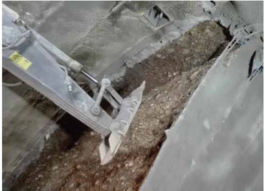
Fig. 3.1.a_ Herramientas para excavar los conglomerados de la L-2
