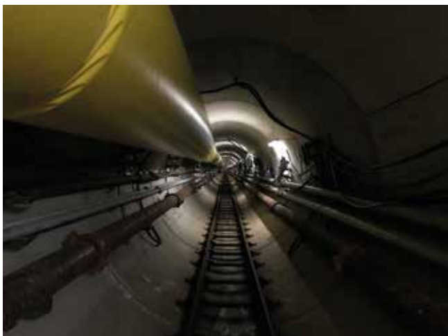
Foto 4_ Interior del túnel durante la fase de ejecución
