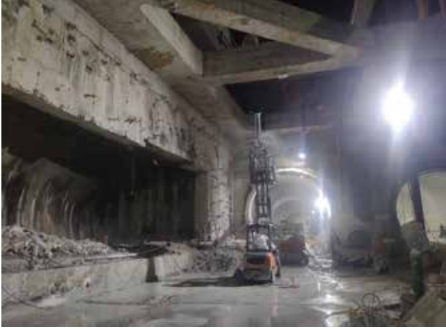
Figs. 7a y 7b_ Corte de la pantalla
