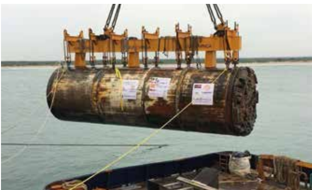
Foto 8_ Maniobra de emplazamiento de TBM sobre la embarcación auxiliar
