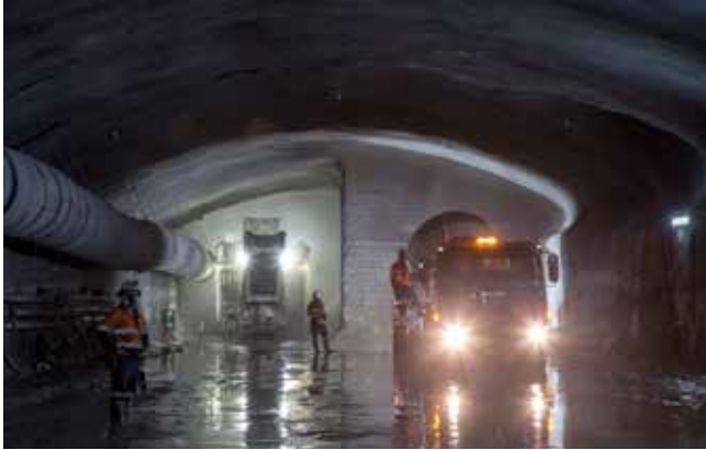
Fig. 7_ Excavación de rozadora simultánea a la proyección de hormigón en túnel de 2 carriles
