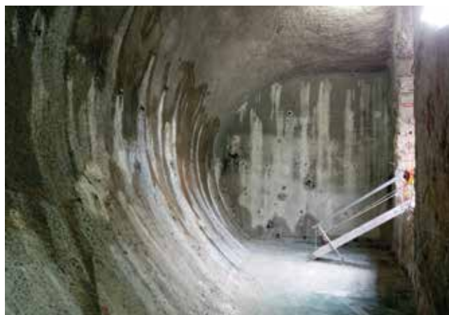
Fig 6_ Excavación completada del nicho antes de corte definitivo de pantalla
