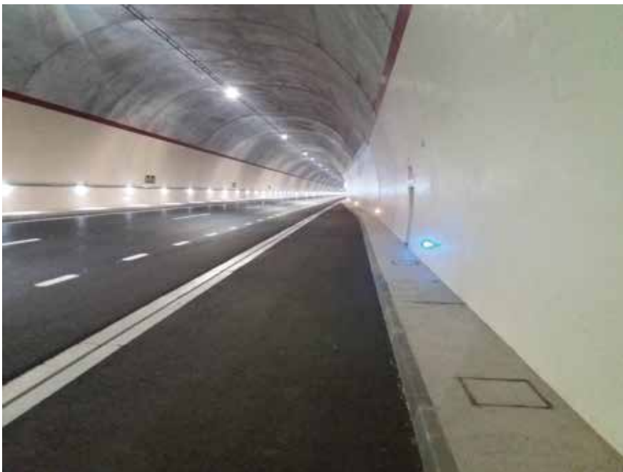
Foto 1_ Detalle del cierre de apartadero
