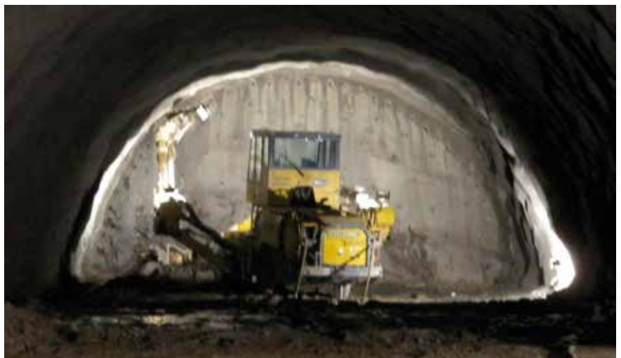
Foto 4_ Frente de avance con jumbo posicionado
