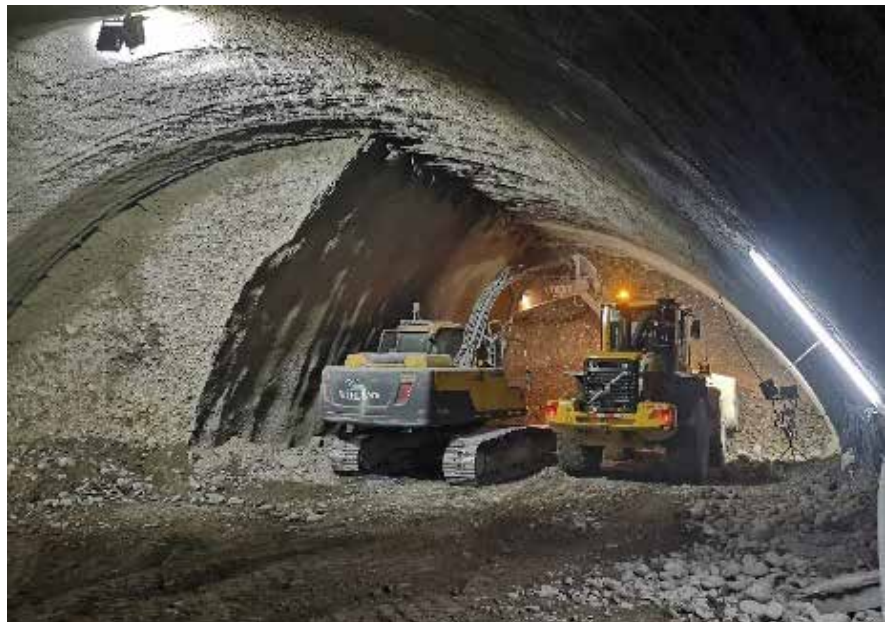
Fig. 3.1.b_ Vista de la retroexcavadora y de la pala utilizada
