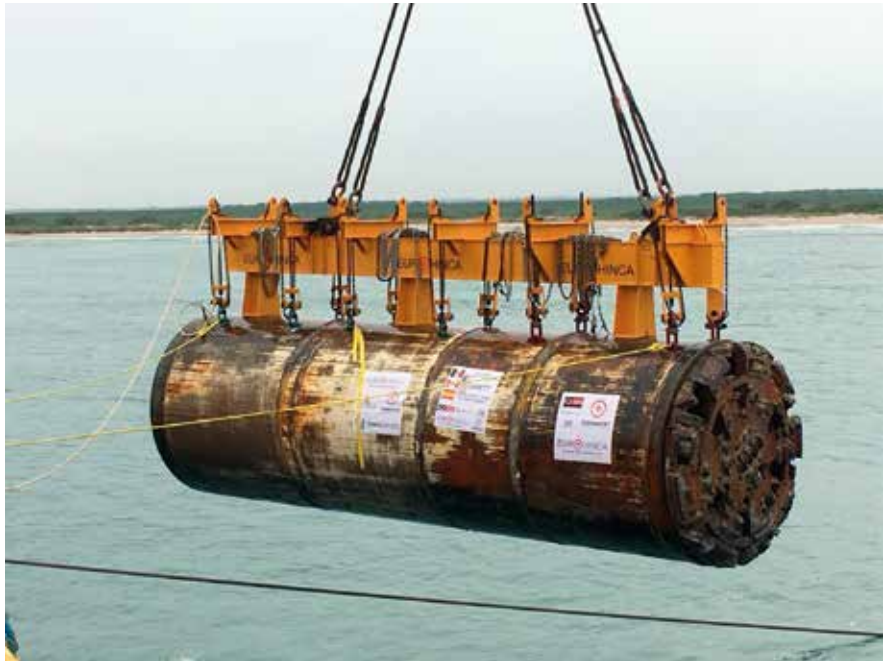
Foto 1_ Rescate de la tuneladora emisario submarino México, Terratest Tunnelling. Fuente: Herrenknecht
