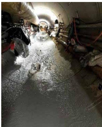
Fotos 5 y 6_ Construcción plataforma (arriba) y extracción de material en el interior del túnel (abajo)
