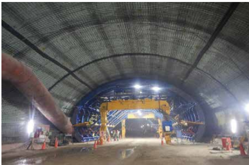
Fig. 3.2.c_ Ejecución del revestimiento de hormigón armado
