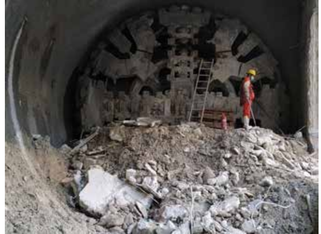
Fig 8_ Excavación para acceder a la cabeza de corte de la EPB
