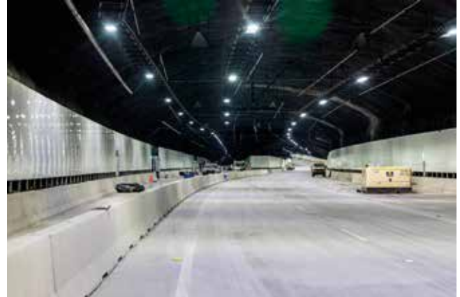
Fig. 10_ Túnel de dos carriles terminado
