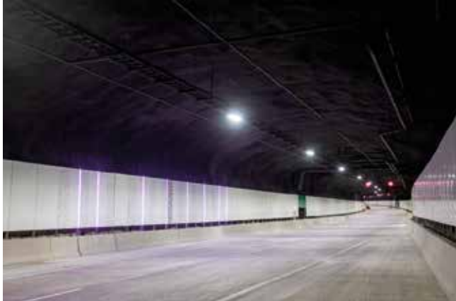
Fig. 9_ Ejecución de acabados en caverna de bifurcación
