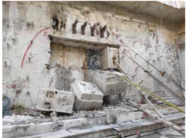
Fig. 4_ Bloques resultantes del primer corte en la pantalla
