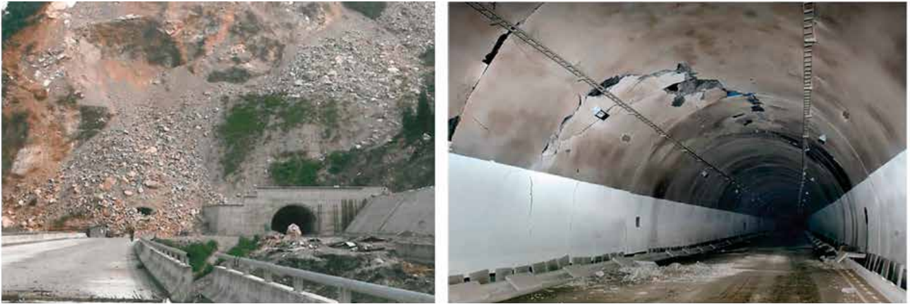
Fig. 2_ Deslizamientos en la boquilla y daños internos del revestimiento en un túnel de carretera, a causa del terremoto de Sichuan (China, 2008). Fuente: Yu et al (2010), Chen et al (2018)
