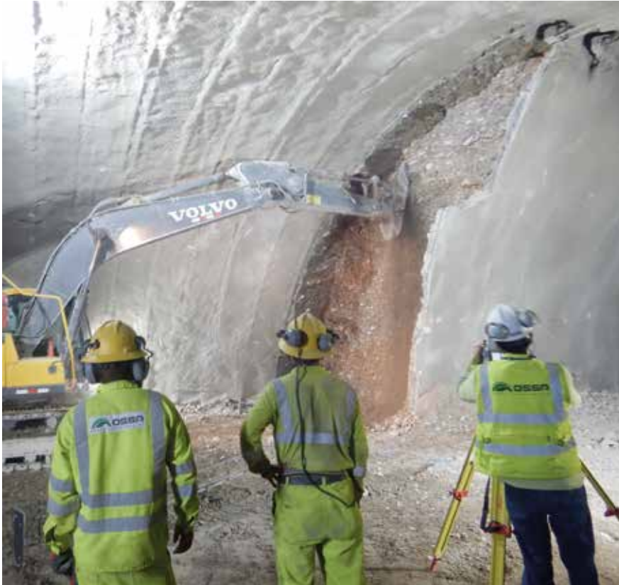
Fig. 3.3.a_ Control topográfico del perfil de excavación
