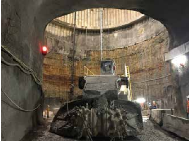
Fig. 4_ Rozadora Sandvik MT720 utilizada con cabeza transversal
