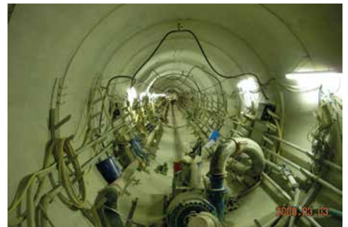
Foto 5_ Tuneladora AVND-4000AB marca HK para los túneles de emergencia de la autopista Berlín-Palermo. Fuente: Herrenknecht (izda.) Foto 6_ Túneles de emergencia durante la ejecución para la autopista Berlín-Palermo. Fuente: Herrenknecht (dcha.)
