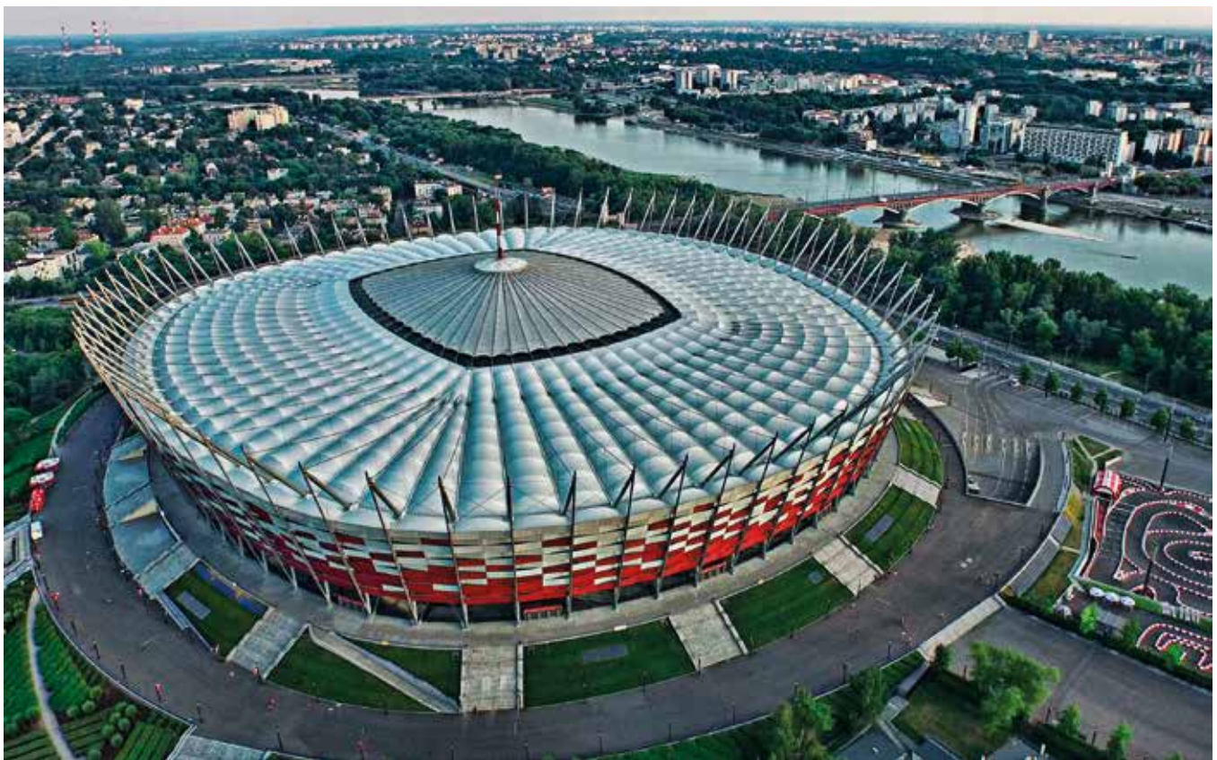
Fig. 1_ Estadio Nacional de Varsovia con cubierta textil (GMP/SBP)
